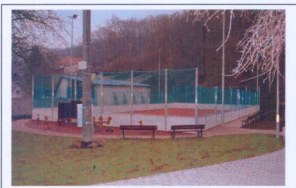
Situácia po ukončení realizácie aktivít projektu
