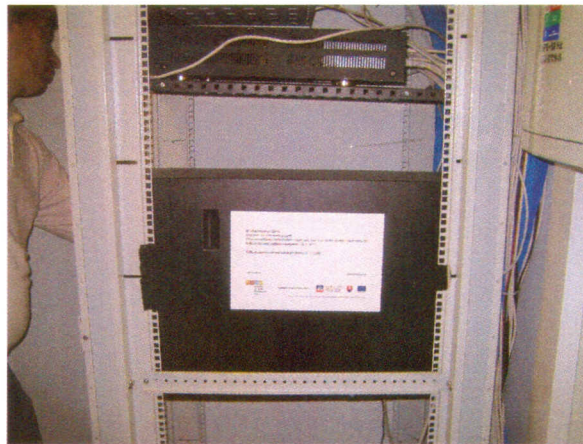
Obrázok č. 4 Montáž servra spolu so sieťovým úložiskom a ich označenie
